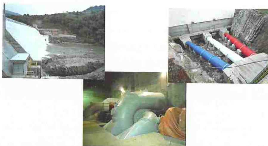
Figura 2.8 – Barragem, turbina e condutos forçados da R.B.H.
